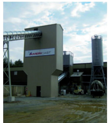
Завод в Ашленде, на котором установлена Exact1500 (Schlüsselbauer), имеет четыре силосные башни вместимостью 60 тонн для заполнителя и еще две силосные башни для цемента и летучей золы. Допускается замена 25% цемента на летучую золу.
